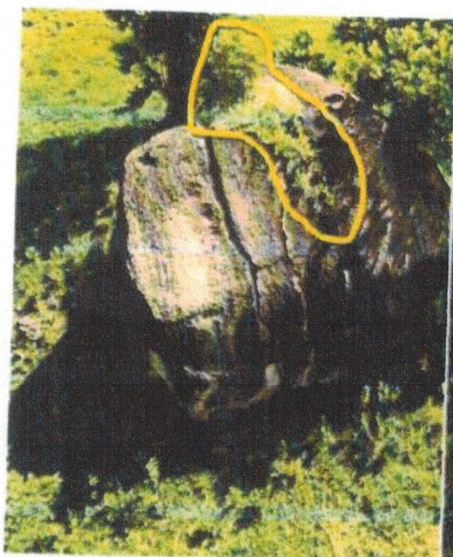
FOTO 03 (DRONE) – Vista parcial superior do bloco rochoso vistoriado onde se observa a presença de vegetação (polígono amarelo) inseridas nas fraturas.
