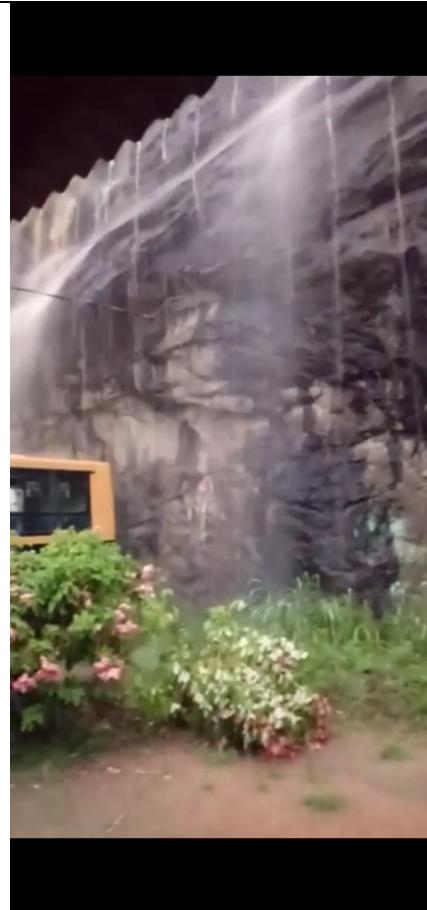
Foto 2. Escoamento de Águas Pluviais
